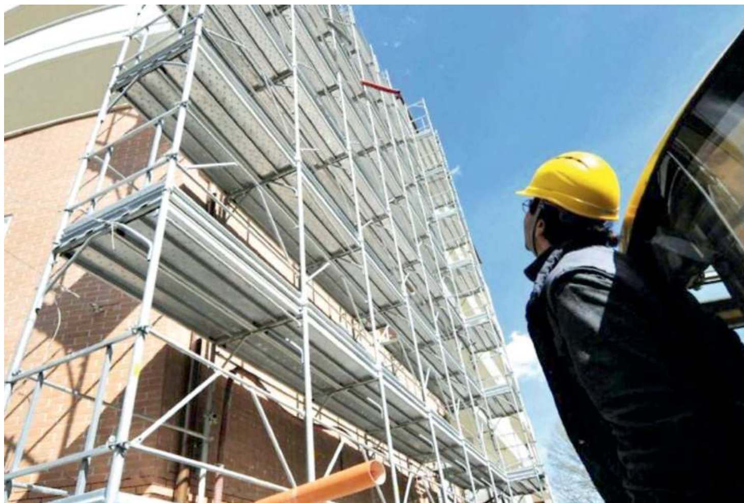
Un cantiere edile (foto d'archivio)
